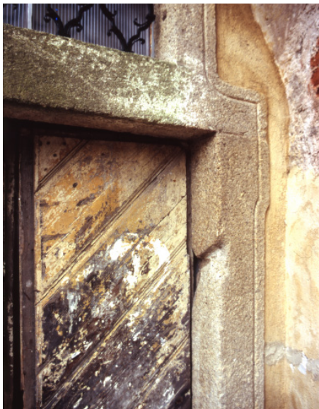
▼ Dochovaný otvor pro mezuzu v kamenném ostění dveří domu New York.
